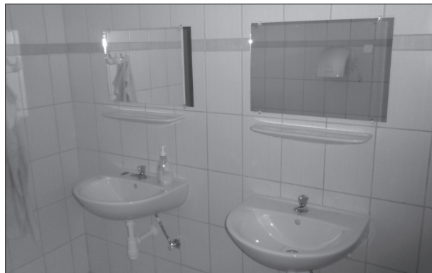
5,5 millió Ft értékben mosdók és tantermek teljeskörű felújítása
