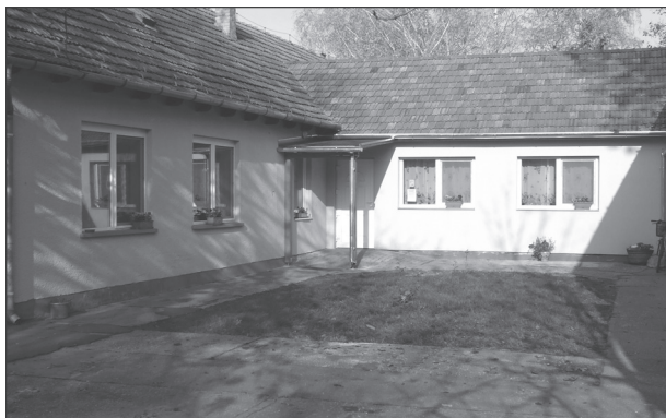
Az óvoda épületén nyeregtető kialakítása 750.000 Ft összegben
