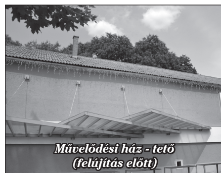
Művelődési ház – tető (felújítás előtt)
